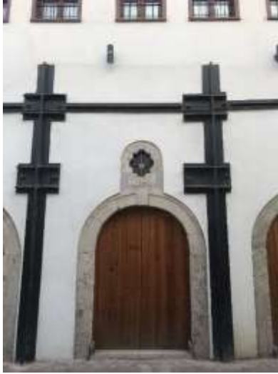
Foto 27. Ön Cephe Görüntüsü
