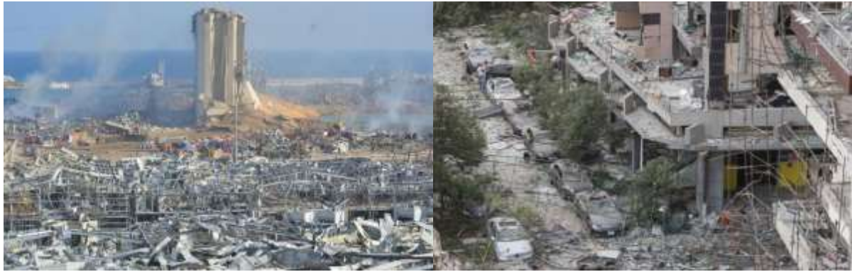
Şekil 5. Havai fişek fabrikası patlaması, Beyrut/Lübnan, 2020, (URL 8)
