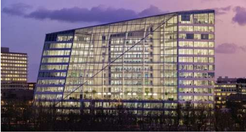
Şekil 8. The Edge- Hollanda (Deloitte Danışmanlık Binası)
